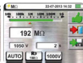
Esito di misura di isolamento
