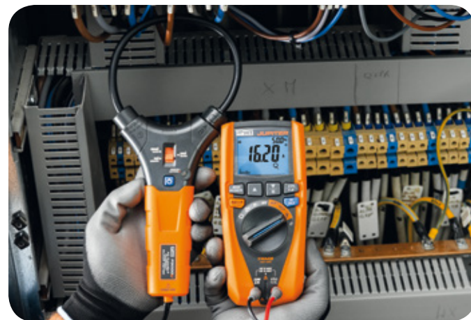
Misura di corrente AC con trasduttore flessibile F3000U.
