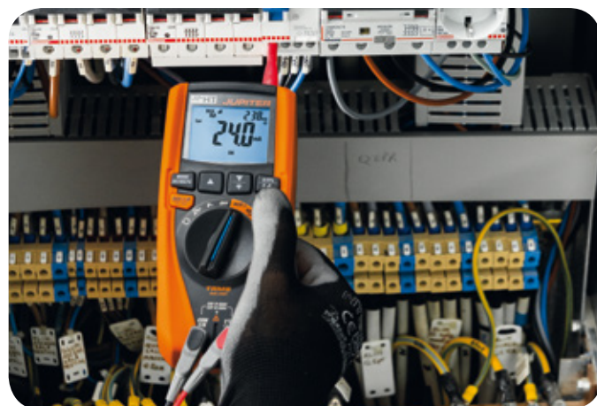
Verifica tempo e corrente d'intervento RCD.
