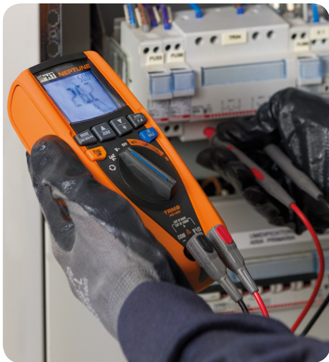
Misura di tensione con puntali di misura.
