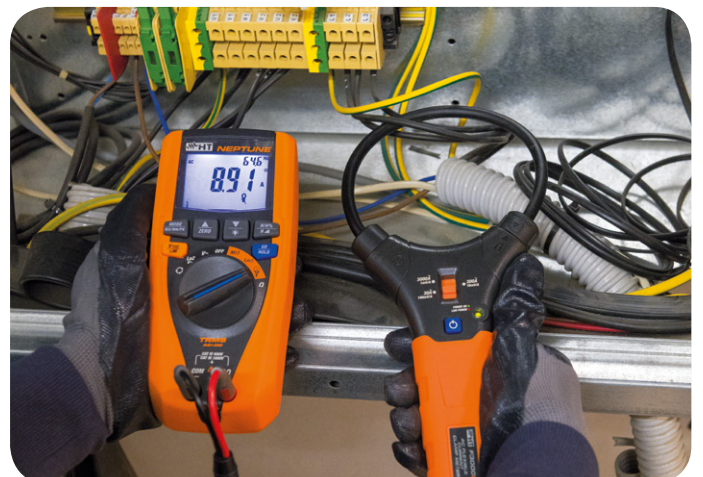
Misura di corrente tramite trasduttore flessibile F3000U.
